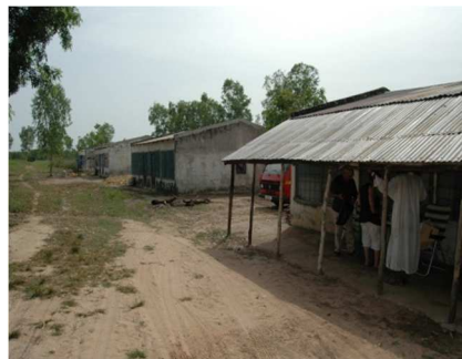
Gebäude auf dem Gelände
