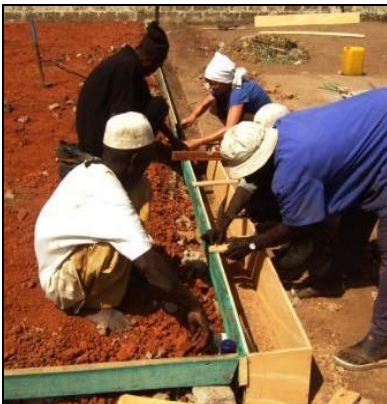
Schalung der Mauerfundamente Typisch: Vier arbeiten, drei stehen nur dumm rum Völlig abgefahren auf Walze
