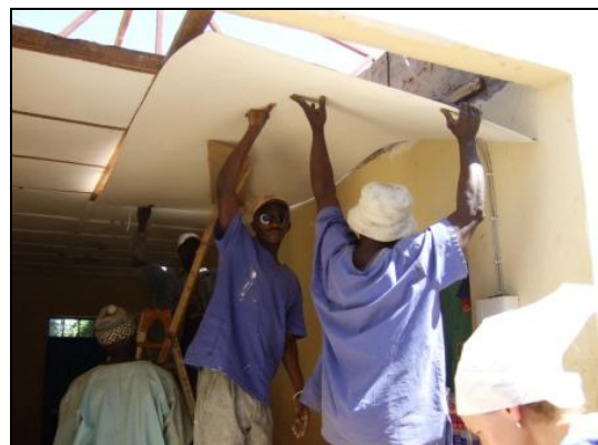
Omar und Moussa wechseln die Deckenplatten
